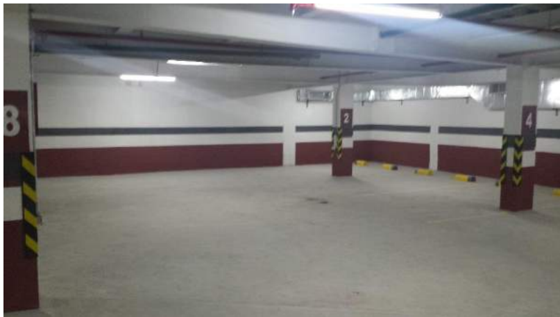
SUBSUELO 1, ESTACIONAMIENTOS DE OFICINAS.
