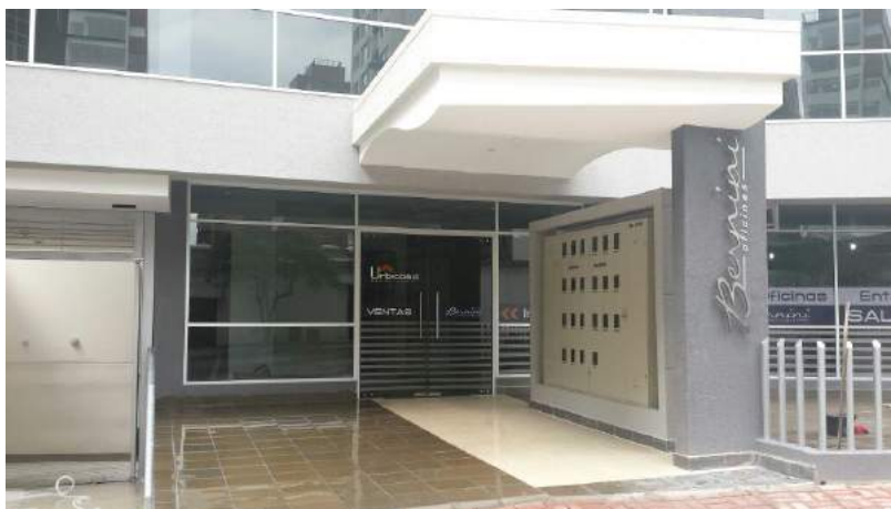
ACCESO A EDIFICIO.
